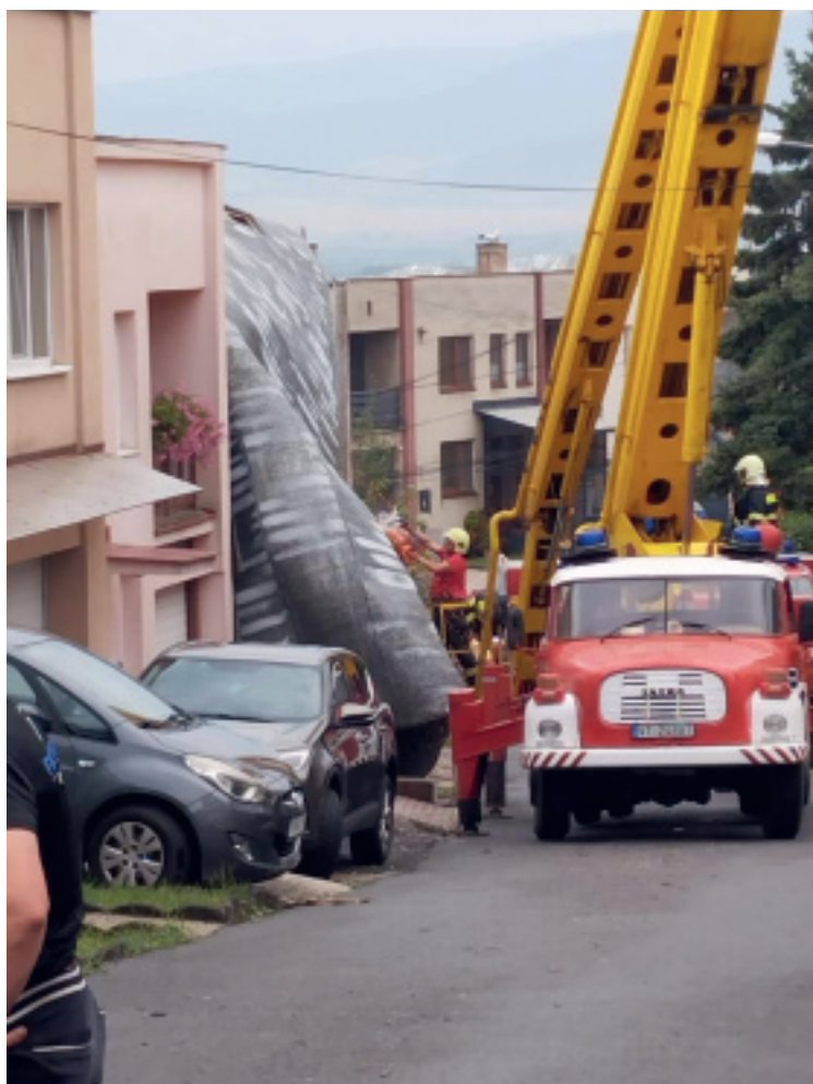
Zásah pri strhnutí strechy vo Vranove n. T.
