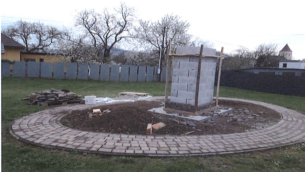
Výstavba pietneho miesta
