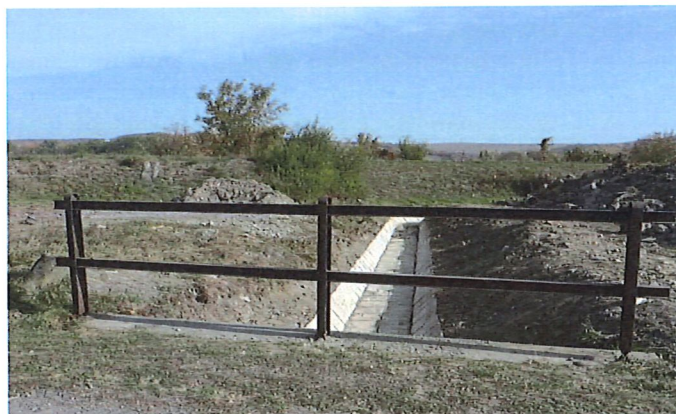
Kanál pri železničnej stanici
