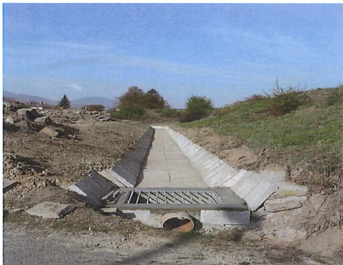
Kanál pri železničnej stanici
